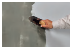
コンクリート面に下地調整モルタルを塗布
